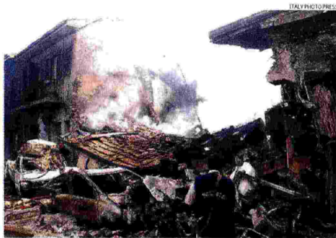
Dopo l'esplosione dei merci. Le case di Viareggio colpite il 29 giugno 2009
