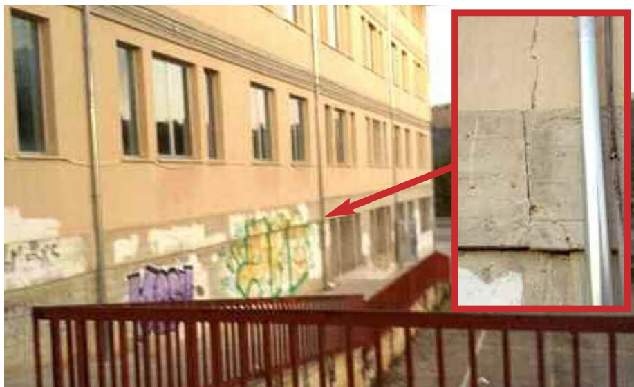
La scuola media D'Alessandro. Nel tondo, le lesioni alla trave tra piano terra e primo piano nei pressi del pilastro
