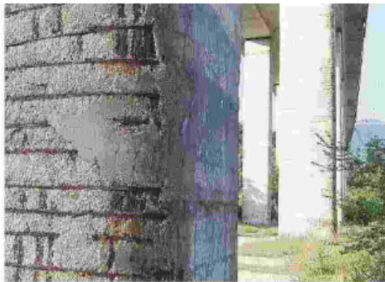
Sulla A25 I piloni del ponte a Pratola Peligna (L'Aquila)
