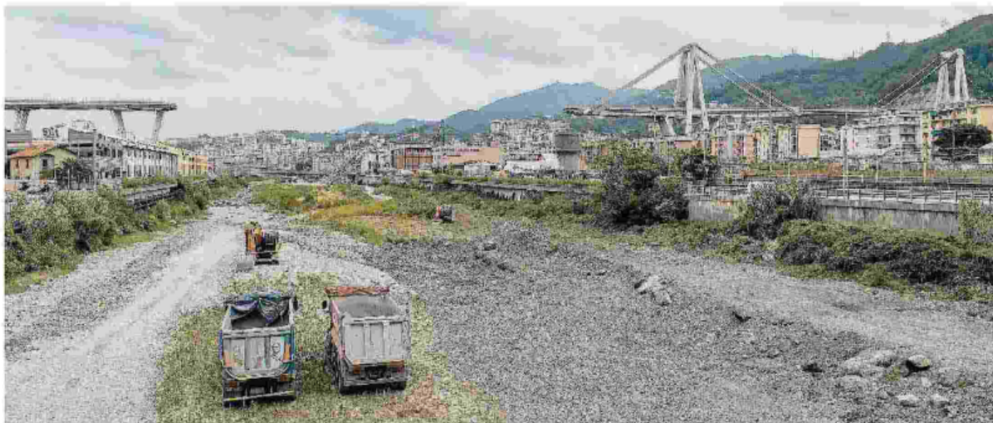
Genova, qual che resta del Ponte Morandi dopo il crollo che ha causato la morte di 43 persone
