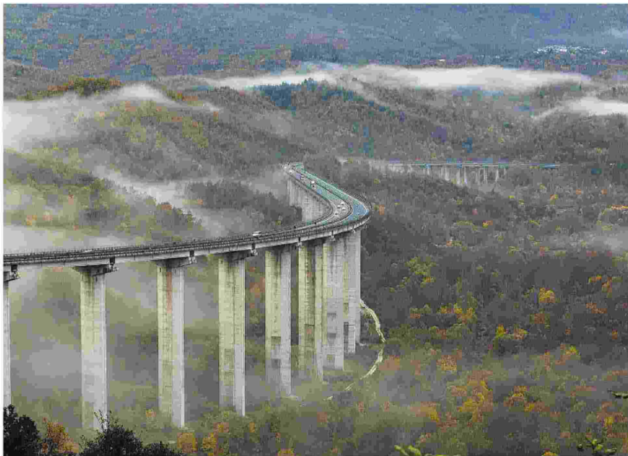
Pietrasecca Il viadotto dell'A24 nel tratto appenninico tra le uscite di Carsoli e Tagliacozzo con i suoi 80 metri è uno dei più alti d'Italia
