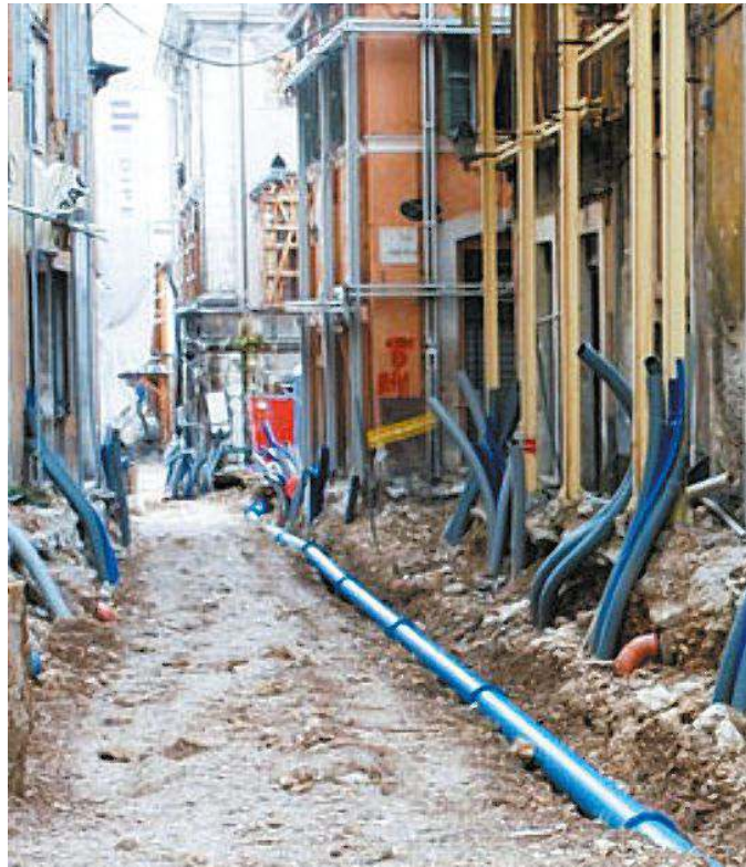
I lavori per la realizzazione del tunnel dei sottoservizi
