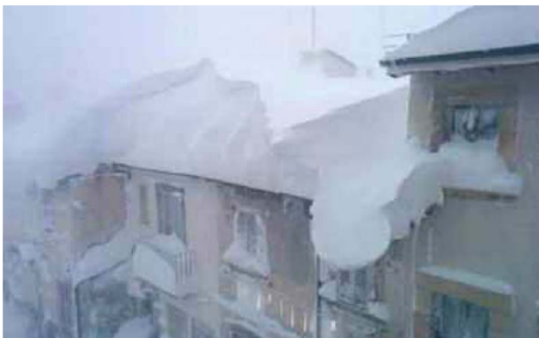
La neve accumulata sui tetti nell'entroterra
