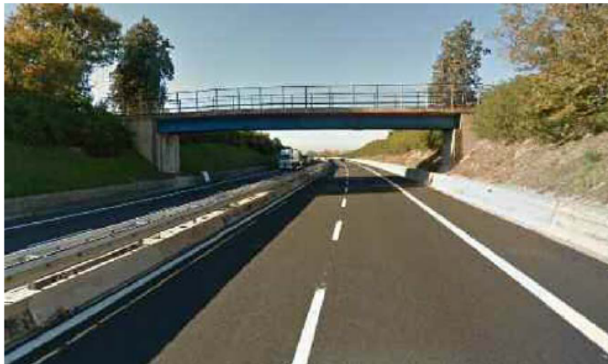
Il cavalcavia 277 chiuso al transito per motivi di sicurezza
