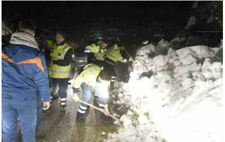
Enel e Protezione Civile al lavoro per ripristinare l'energia
