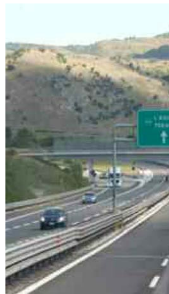
Lo svincolo di Torano tra A24 e A25
