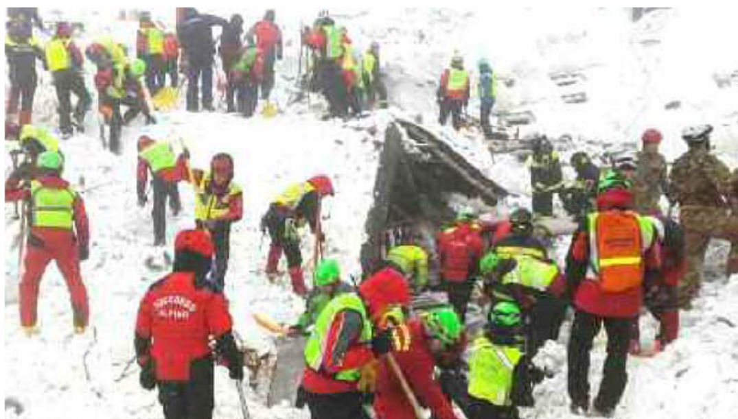
I soccorritori al lavoro all'hotel Rigopiano
