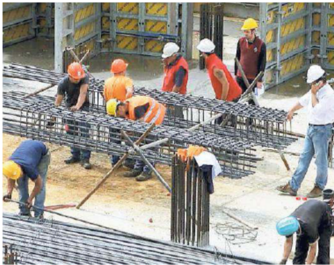
L'immagine di un cantiere edile
