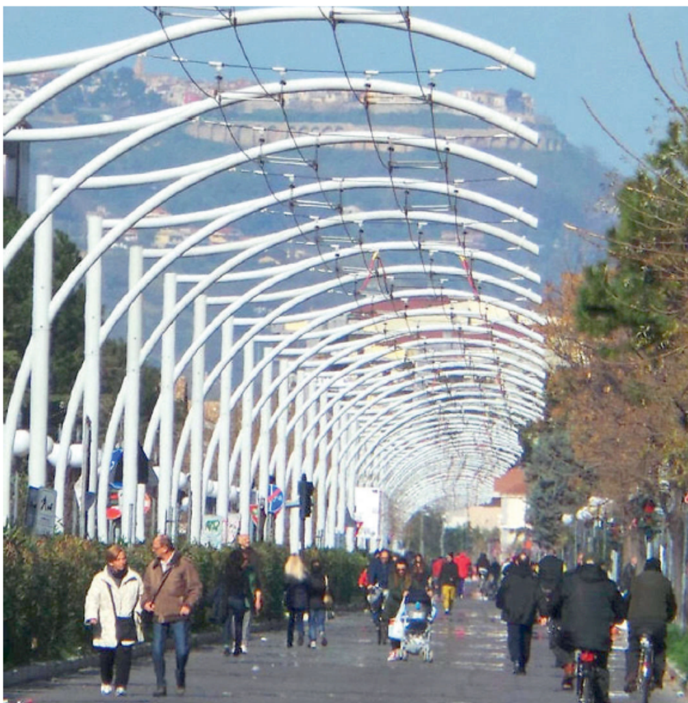
I pali elettrificati per la filovia sulla Strada parco che saranno trasformati in punti luce (foto Domenico Logozzo)
